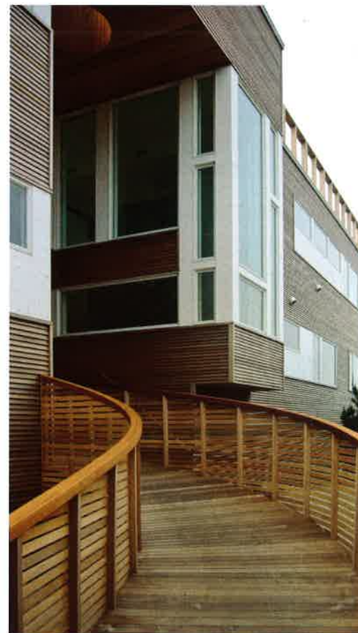
Entrée. Les deux volumes d'habitation sont connectés l'un à l'autre
