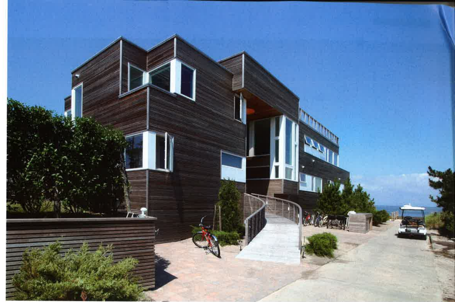
Arrivée à bon port. Le bois et le blanc sont la marque de fabrique de la maison. Le ponton incurvé est un symbole des passages aisés constants entre l'extérieur et l'intérieur. Il a par ailleurs été très pratique pour acheminer les matériaux et le mobilier !
